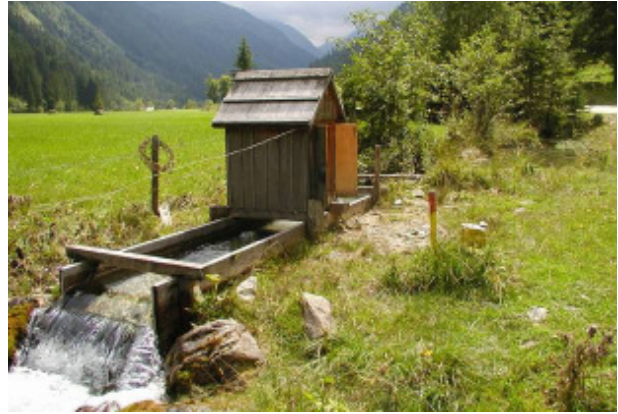
Abbildung 2: Messwehr Preunegger Sieben- quellen
